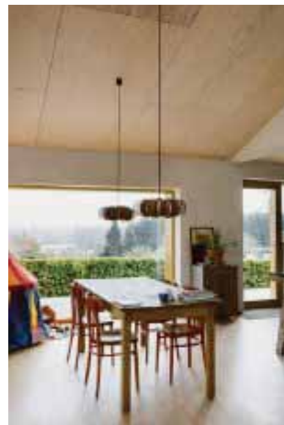
Het plafond bestaat uit geoliede multiplexplaten.
