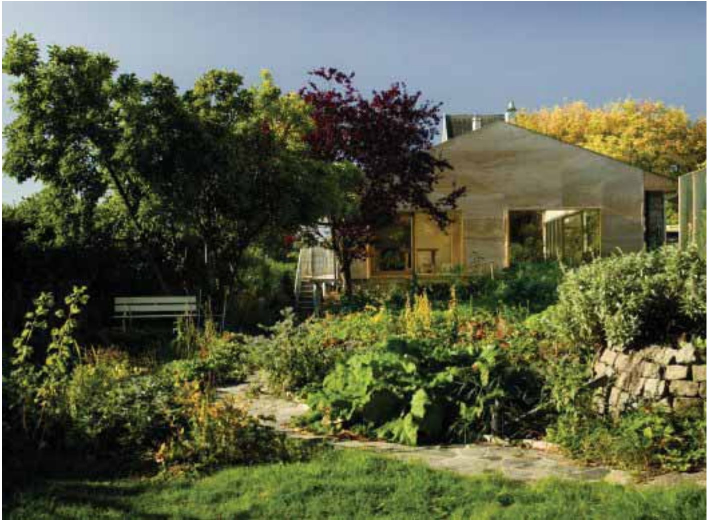
Het kalkhennepbeton op de gevel is een erg duurzaam materiaal. Het is volledig recycleerbaar. En het oogt nog mooi ook.
