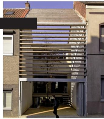
Abb. 17) Eine Holzstruktur dient beim Haus Ele in Steendorp als Filter zwischen dem Innenhof und der Straße. cuypers & Q architecten, 2005 © cuypers & Q architecten
