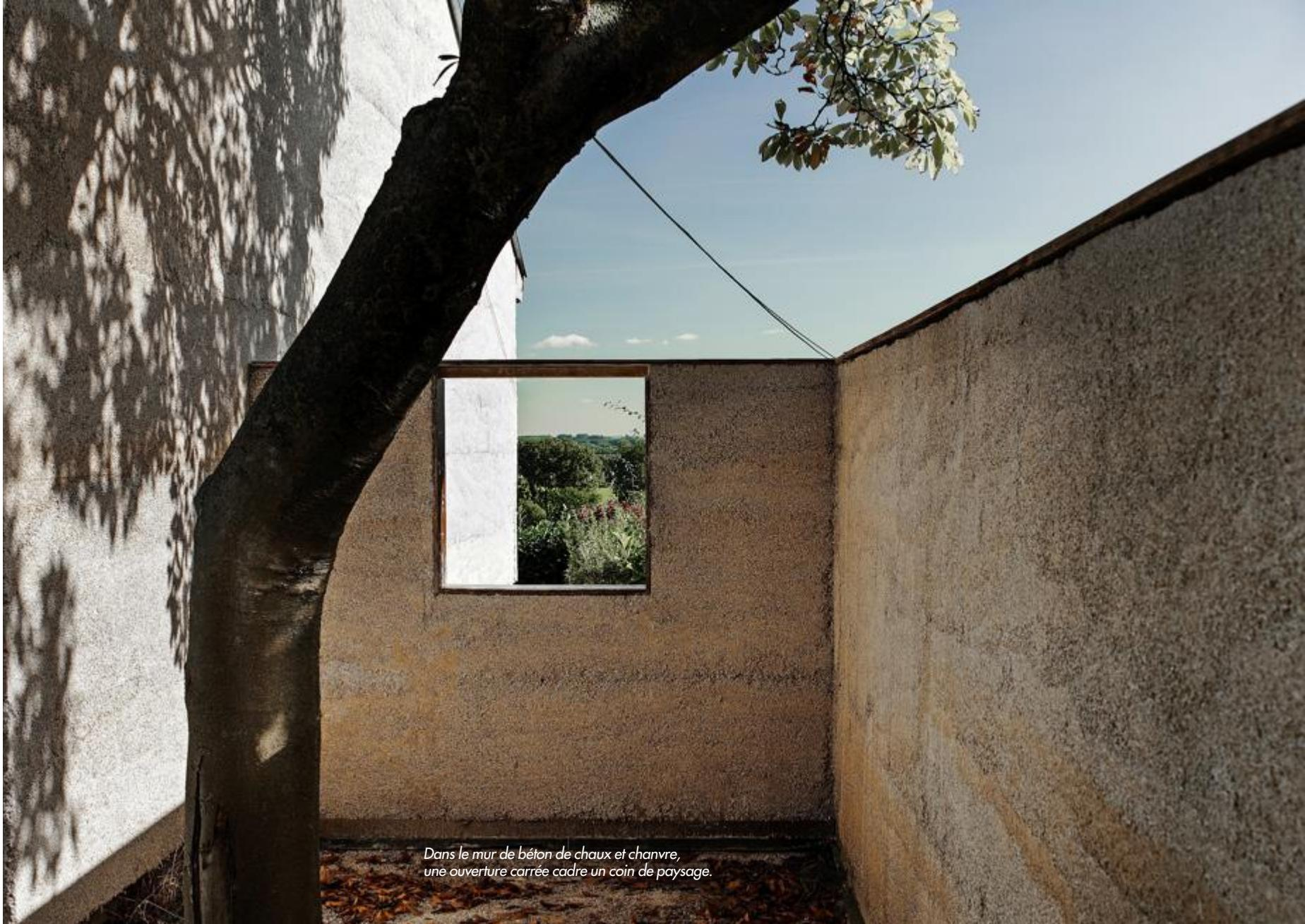
*Dans le mur de béton de chaux et chanvre, une ouverture carrée cadre un coin de paysage.*
