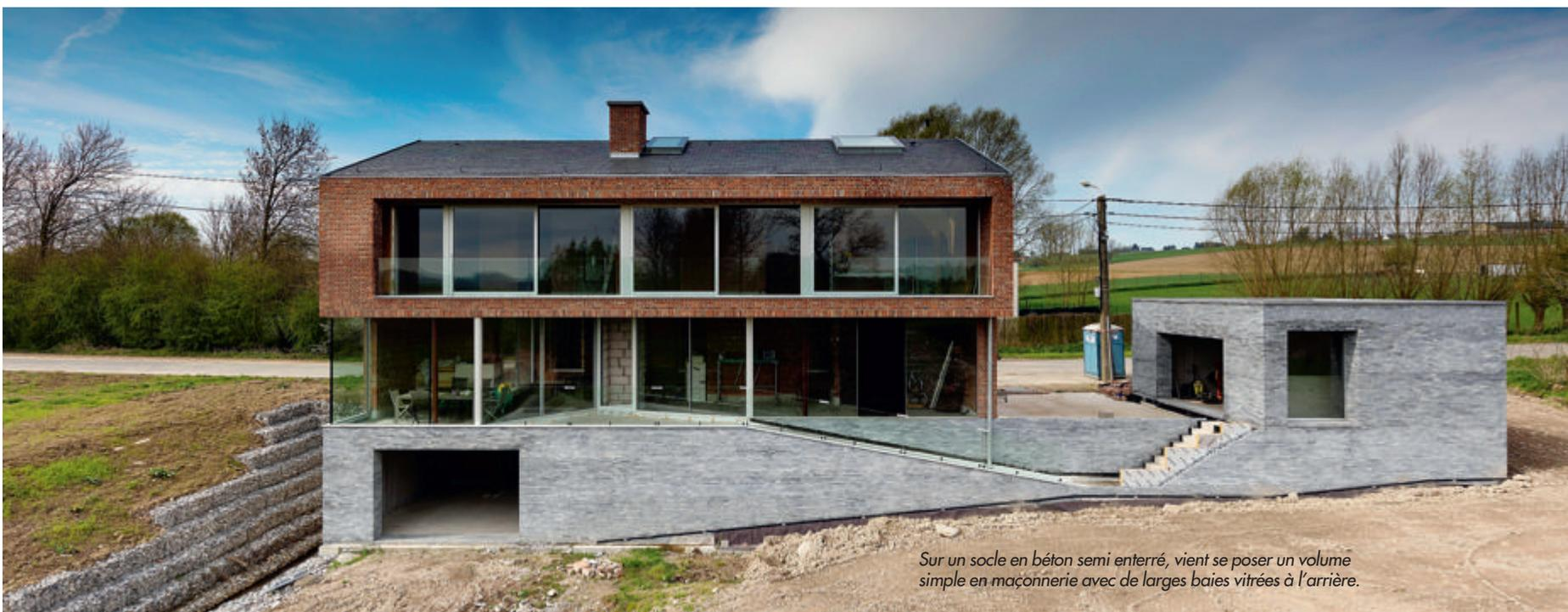
*Sur un socle en béton semi enterré, vient se poser un volume simple en maçonnerie avec de larges baies vitrées à l'arrière.*
