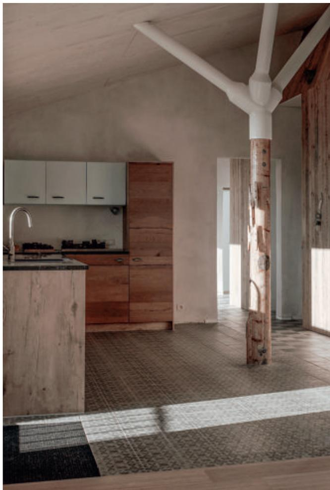
*A partir d'un ancien mât de bateau, MVC a réalisé une colonne pour soutenir le toit existant. Les branches de soutien sont reliées par un élément en acier thermolaqué qui évoque le feuillage du magnolia.*
